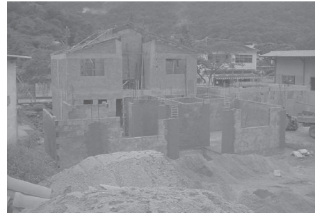
Construcción de viviendas familiares; Progreso de la albañilería
