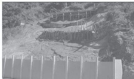
Ejecución de muro atirantado, muro en roca y hormigón proyectado.
