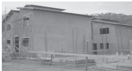
Construcción de viviendas familiares; Ejecución del revestimiento externo
