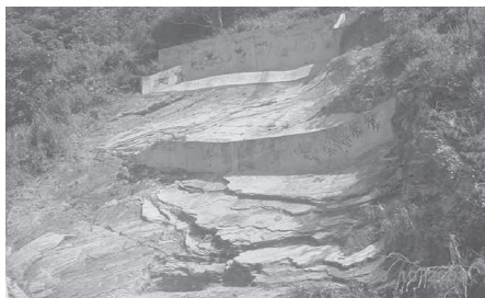
Muro atirantado, muro en roca y hormigón proyectado ejecutados.
